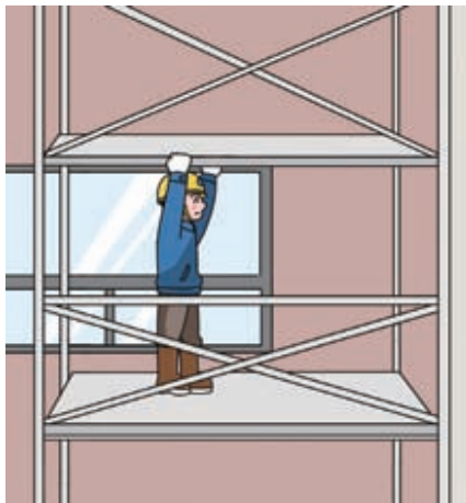
② 상부 작업발판 설치
