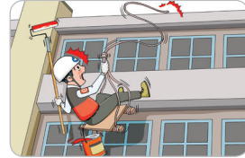
달비계를 사용하여 건물 외벽 청소에 구명줄 미설치
