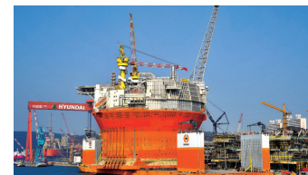
2015 02 세계 최대 원통형 골리앗 FPSO 출항
