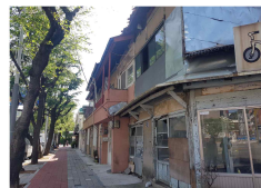
9 진해 창선동 근대상가주택
